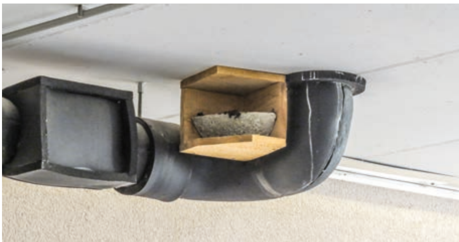
Der Schwalbenwinkel im Einfahrtbereich einer Tiefgarage.
